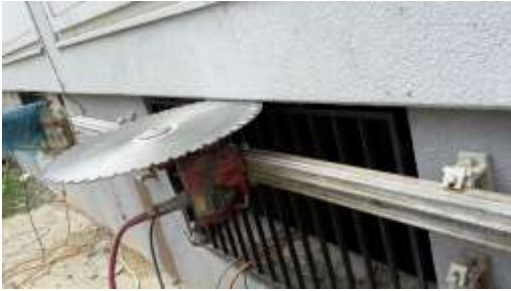
Betonsäge (unten), Öffnen des Tür-/Fensterelements zum Busbahnhof (rechts)
